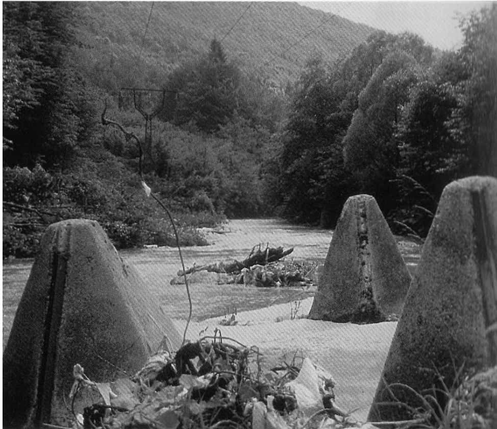
7. kép Harckocsiakasztó-gúla Volócon, a Vecsa patak medre.
